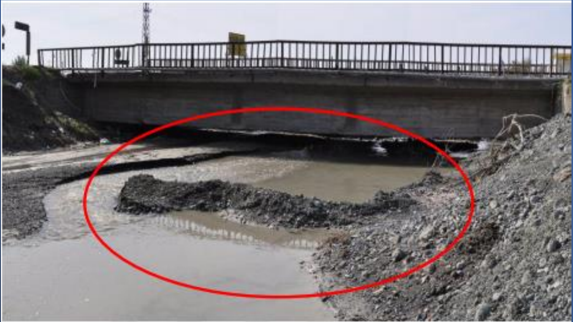
Resim 4.40. Dörtyol-Adana eski karayolu üzerindeki köprü civarında rüşubat birikmesi
