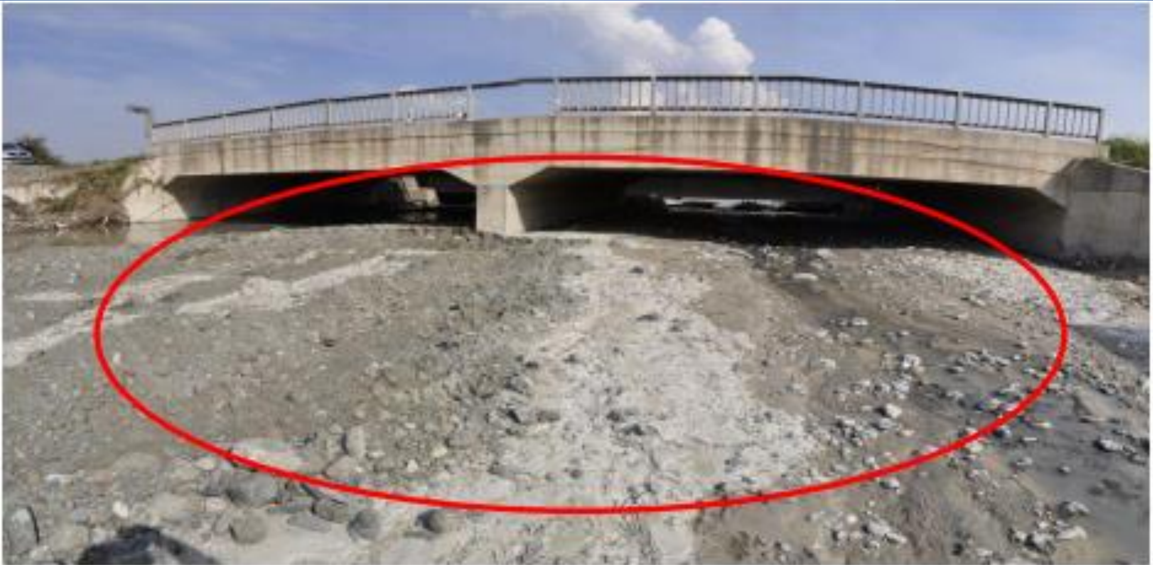
Resim 4.41 Payas ilçesi dere kesiti içerisinde rüsubat birikmesi
