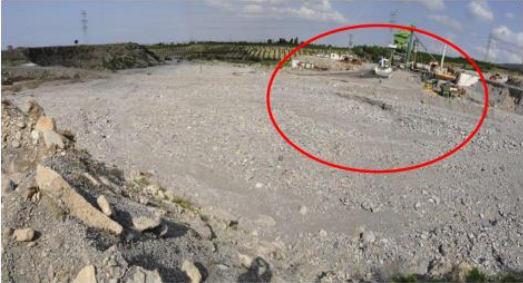
Resim 4.34. Payas ilçesi Çağlalık mahallesinde bulunan kuru deresi içerisinde asfalt şantiyesi, kum ocağı ve taş ocağı
