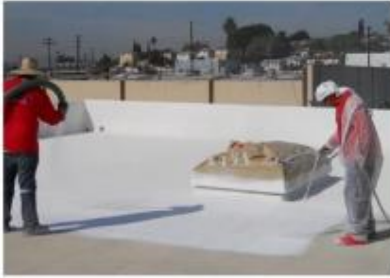
Düşük Eğimli Çatıya Sıva Püskürtülmesi, Serin Çatı Üzerinde Fotovoltaik Güneş Panelleri Montajı
