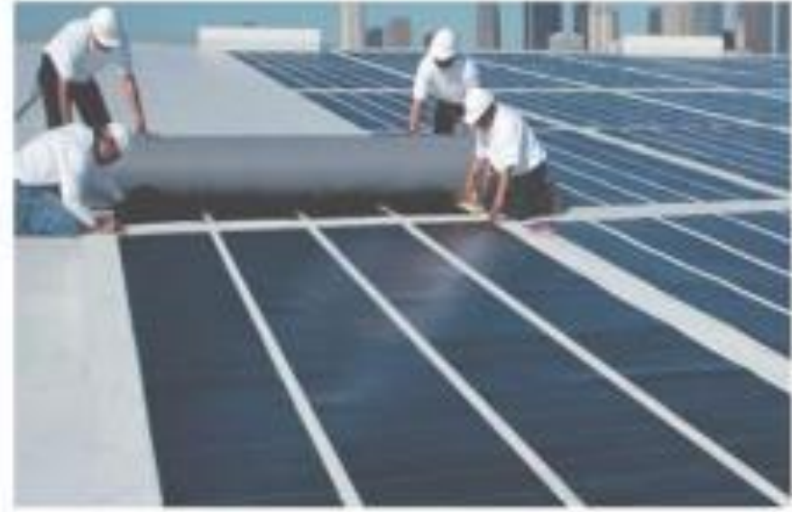
Düşük Eğimli Çatıya Sıva Püskürtülmesi, Serin Çatı Üzerinde Fotovoltaik Güneş Panelleri Montajı
