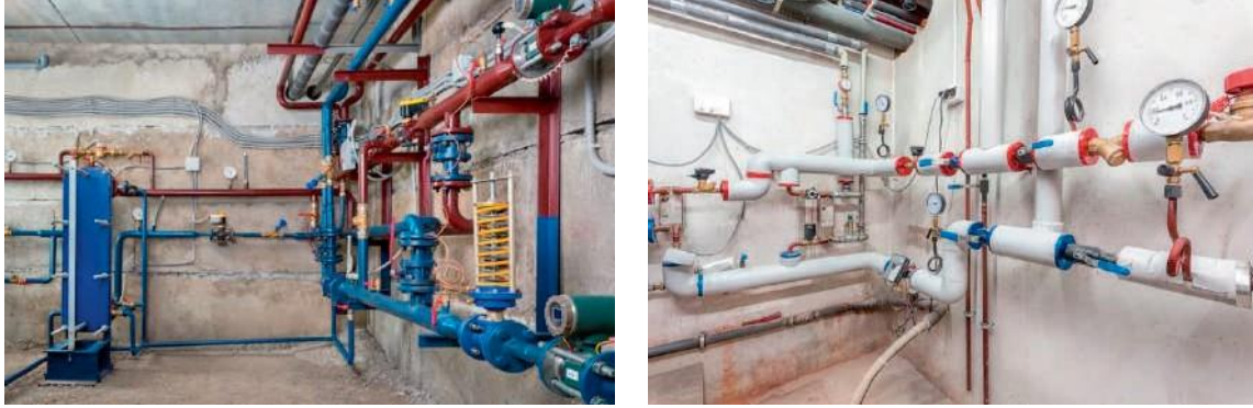
Şekil 8. Hava kompanzasyon kontrollü bağımsız otomatik ısı noktası
