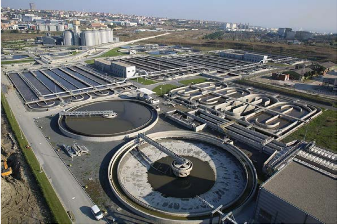
Ambarlı İleri Biyolojik Atıksu Arıtma Tesisi
