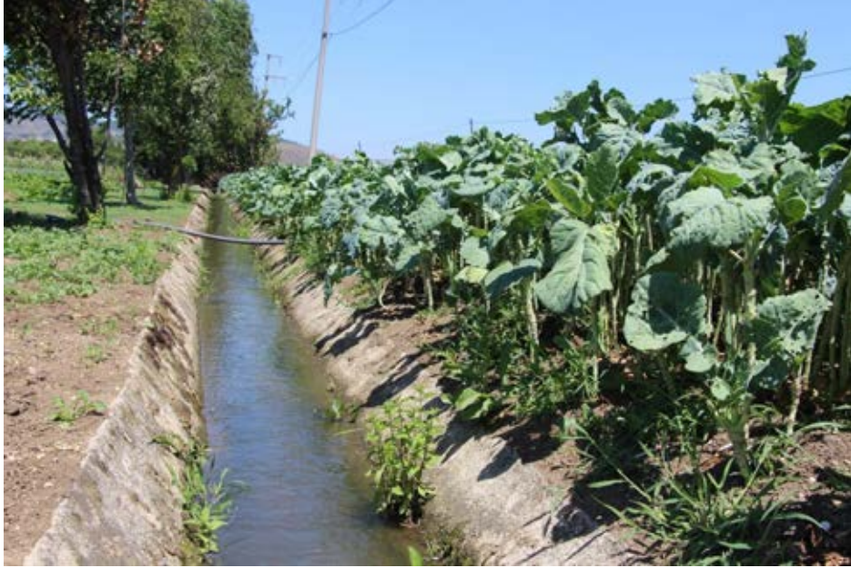
Açık Beton Kanal Sistemi ile Sulama Çalışmaları
