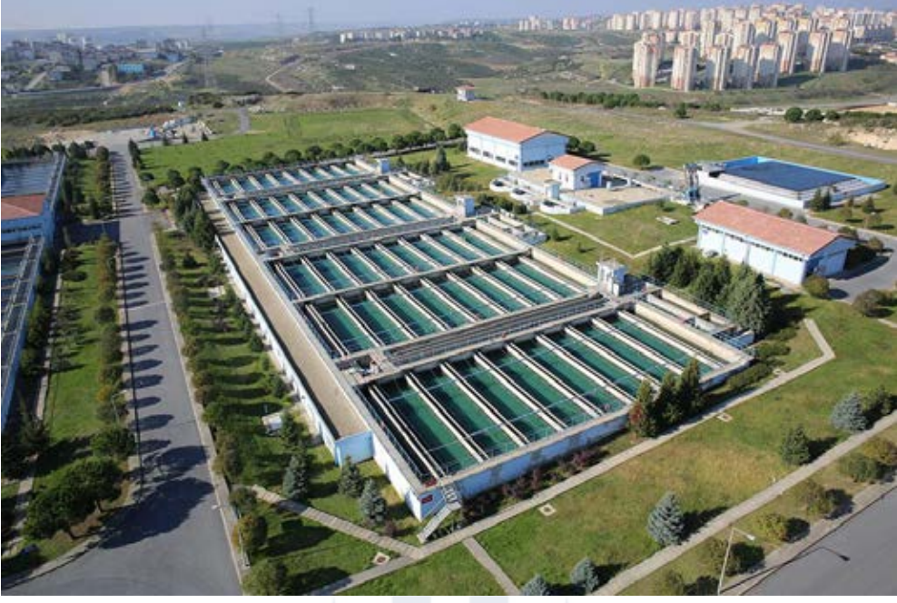
İkitelli Su Arıtma Tesisi
