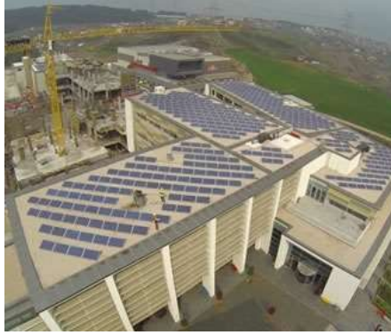
řekil 5. zyeđin niversitesi zyeđin niversitesi Gneř Enerjisi Santrali
