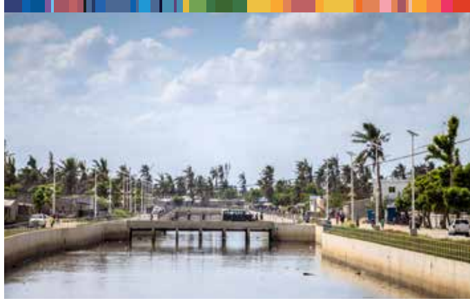
Mozambik'in Beira kentinde dayanıklılığın oluşturulmasına yardımcı olan bir yağmur suyu drenaj sistemi. Şehirde doğa temelli çözümlerin uygulanması da dahil olmak üzere dayanıklılık oluşturma müdahaleleri, şehrin 2019'da İdai Kasırgası'nın etkileri. -FOTOĞRAF SARAH FARHAT / DÜNYA BANKASI
