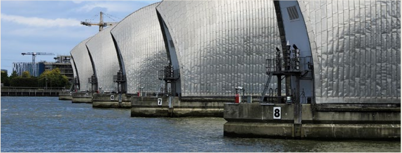
Thames Bariyeri, 1,3 milyon insanı koruyan fırtına dalgalarını ve yüksek gelgitleri engellemek için çalışıyor.
