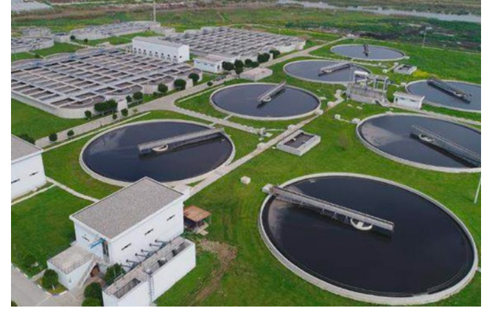
Şekil 4: Mersin atıksu arıtma tesisleri. Kaynak Mersin
