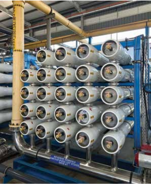
Enerji tasarrufu sağlayan biyomimetik membran Kranji NEWater fabrikasında denendi
