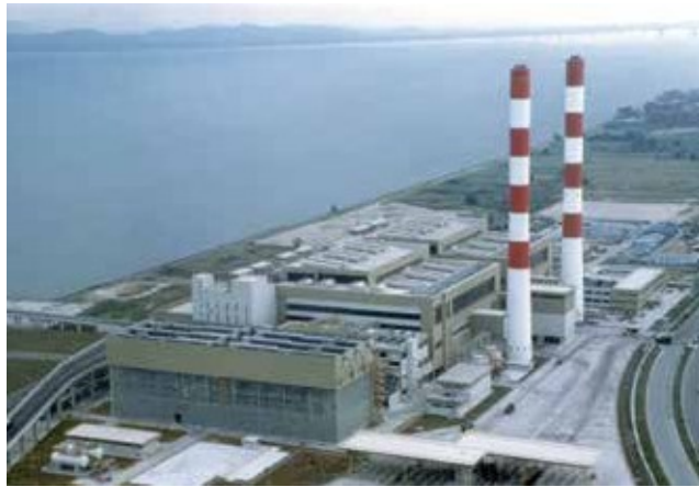
Singapur'un 4 üncü Atıktan Enerji Üretim Tesisleri olan Tuas Güney Yakma Tesisleri'nin havadan görünümü
