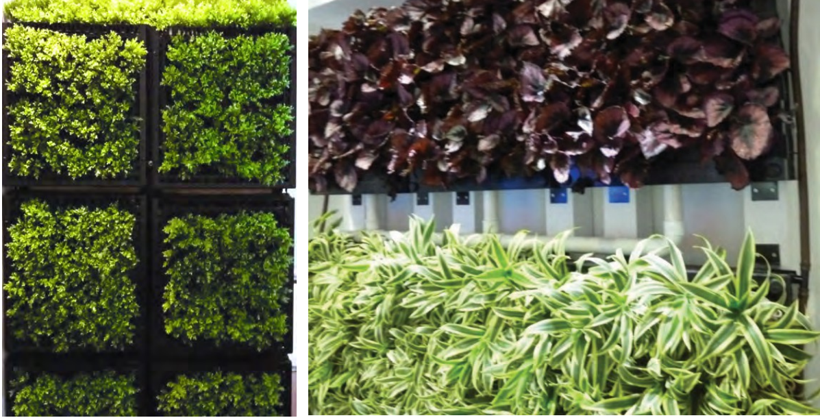
Şekil 4.11.3: Sulama ve kendi kendine drenaj teknolojileri ile gömülü yeşil cephe modüler sistemi
