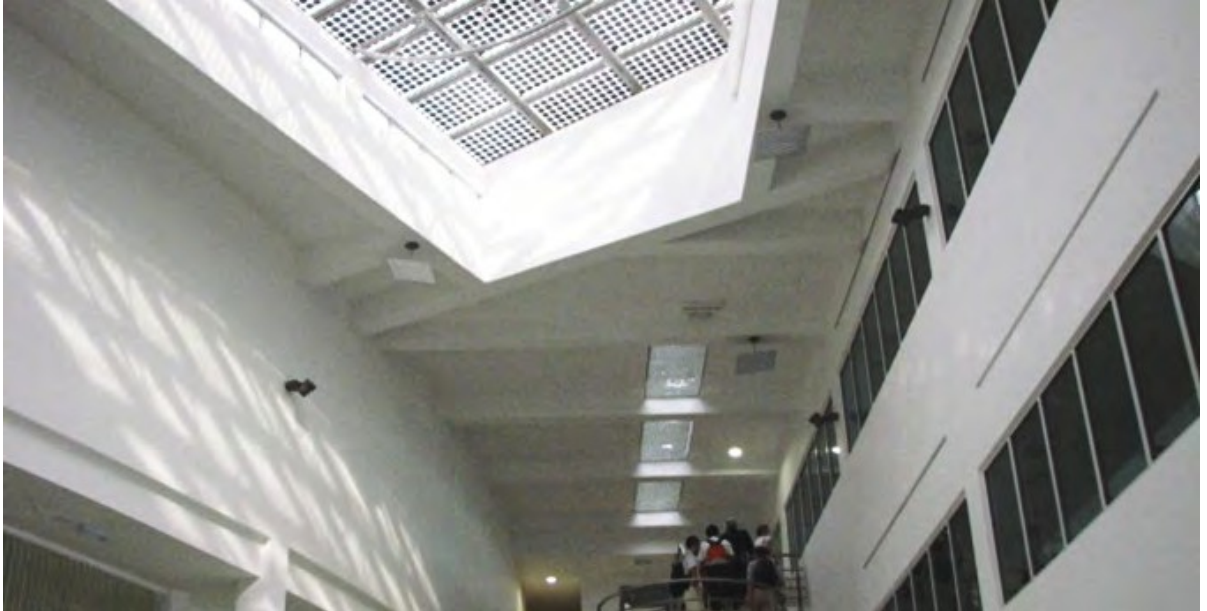
Şekil 4.12.3: BIPV: Bir atriyum üzerindeki çatı penceresinin cam panelleri arasına sıkıştırılmış PV modülleri
