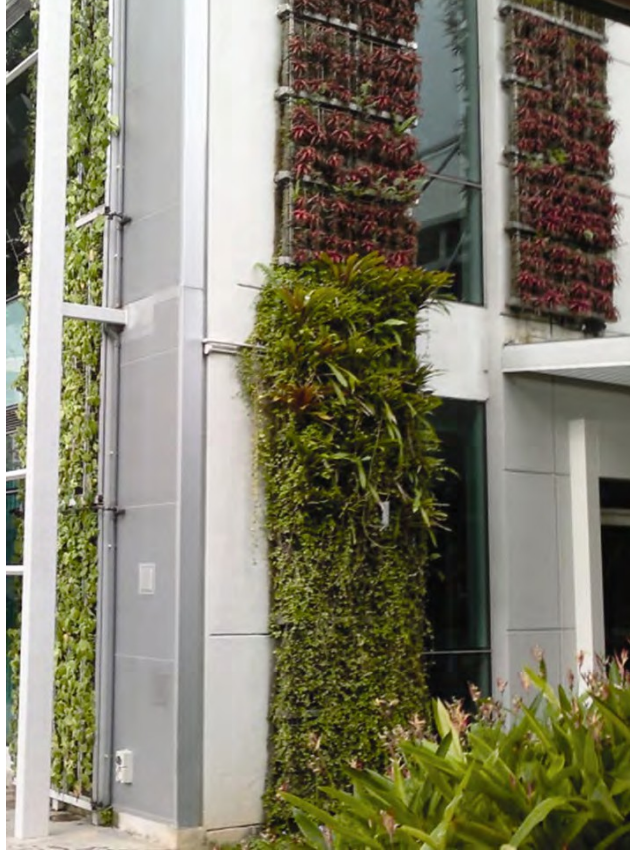
Şekil 4.11.10: Yeşil duvar, bina cephesindeki günlük sıcaklık dalgalanmalarını azaltmaya yardımcı olur.
