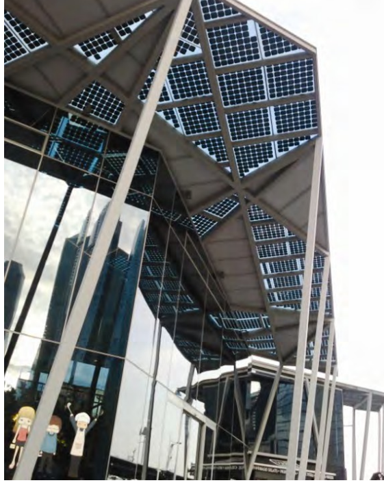
Şekil 4.12.2: Bina tasarımının ayrılmaz bir parçası olarak PV panelleri
