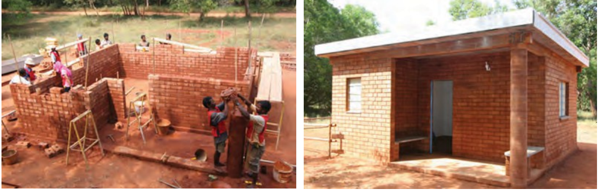
Şekil 4.1.5: Auroville, Hindistan'da inşaat halindeki (solda) ve tamamlanmış (sağda) taşınabilir ev
