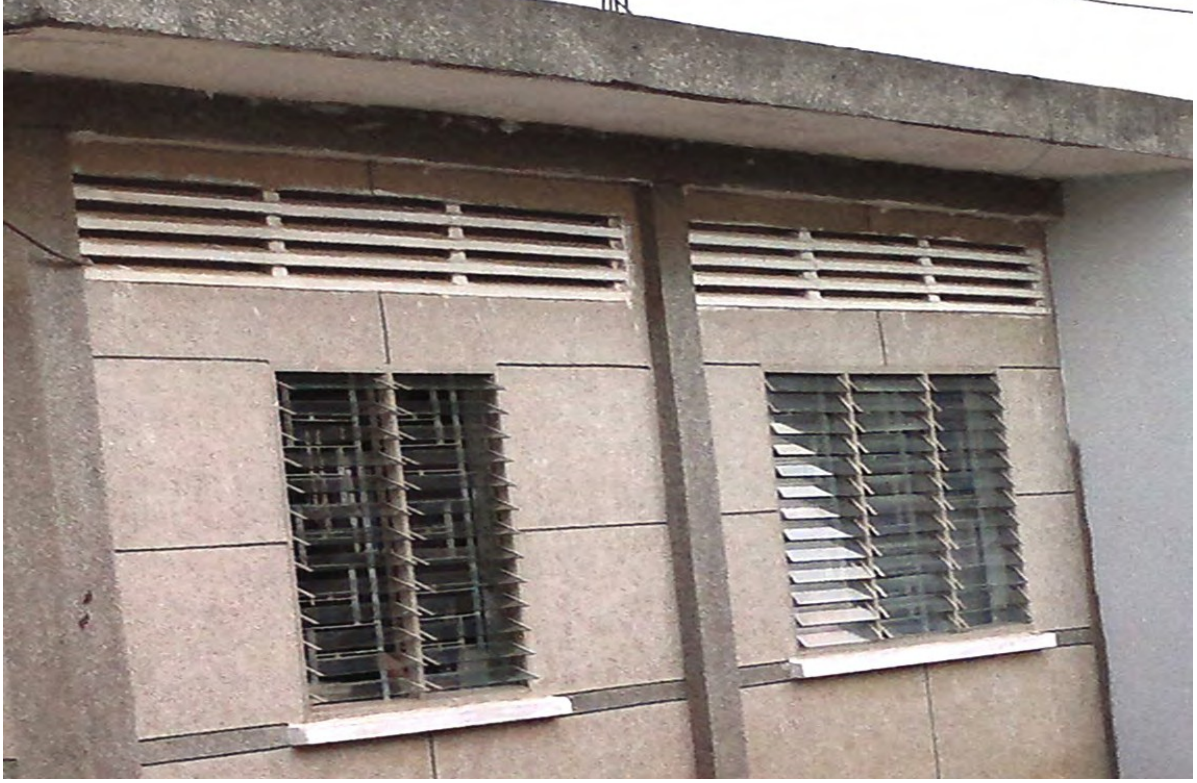
Şekil 3.2.8: Vietnam'da bir ev için doğal havalandırma ile gün ışığı erişilebilirliğinin birleştirilmesi
