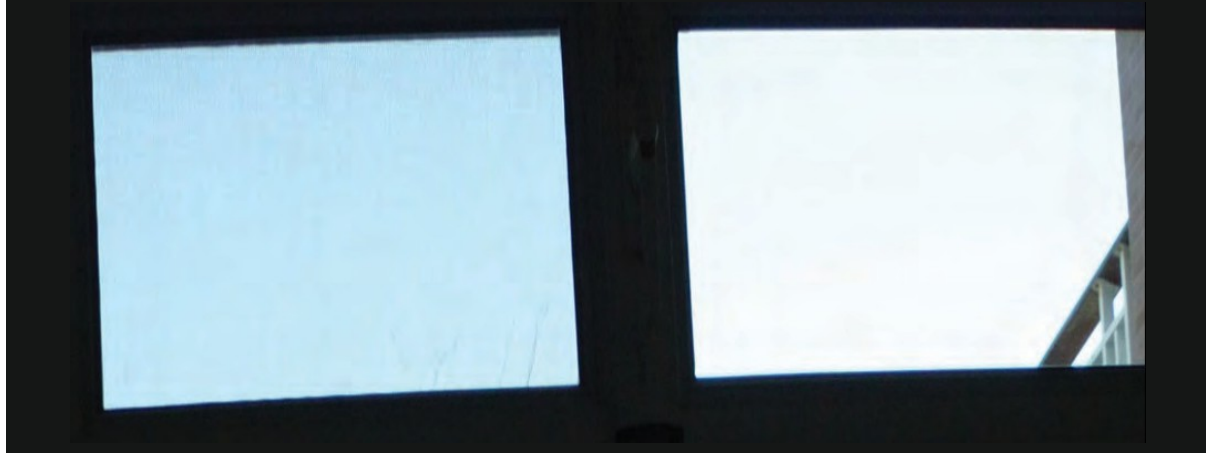
Şekil 4.5.5: Parlak gün ışığı ortamında fotokromik cam (solda) ve şeffaf cam (sağda)
