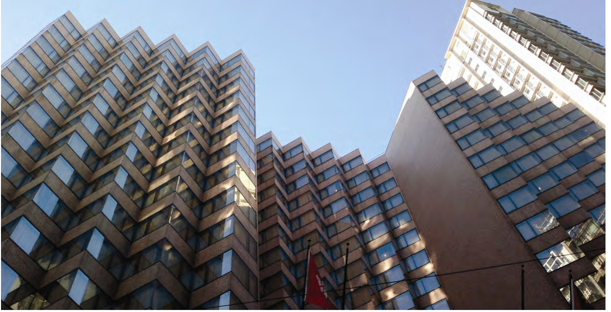
Şekil 3.2.4: Bina kütleleri kendi kendini gölgeleme etkisi yaratır - yani, çoğu pencere soldan gelen sıcak güneş ışığından gölgelenir
