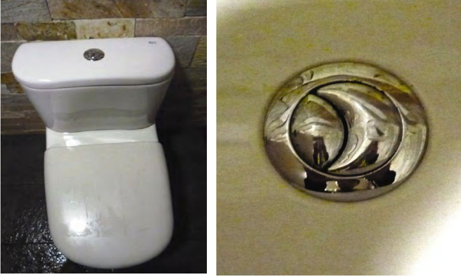
Şekil 4.9.4: Çift sifonlu rezervuarlı tuvalet.
