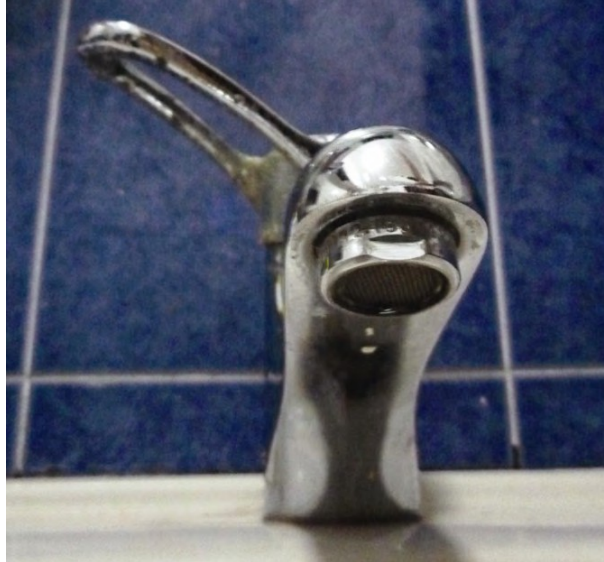
Şekil 4.9.8: Su verimliliği sağlamanın basit bir yolu olarak musluğa takılan havalandırıcı
