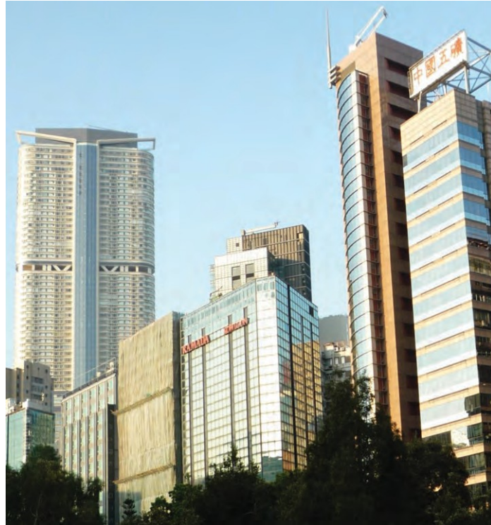
Şekil 4.5.2: Bu resimde Hong Kong'da olduğu gibi, kentsel dokuda sıklıkla bulunan çok çeşitli bina cepheleri
