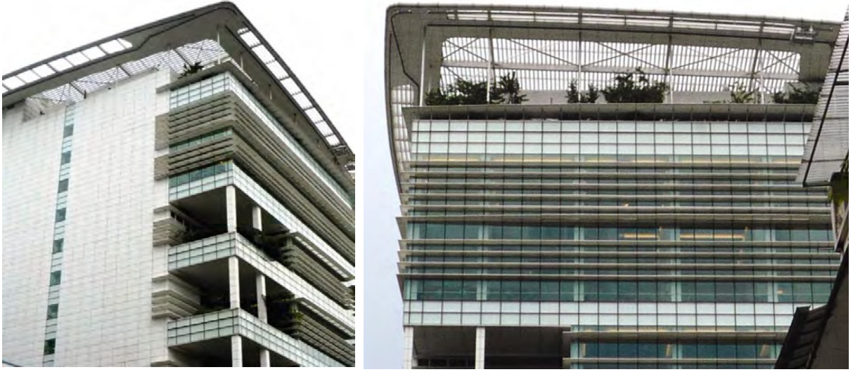
Şekil 4.5.12: Singapur'daki Ulusal Kütüphane Binası'nın düşük ETTV'li cephesi çift cam, uygun duvar/pencere oranı ve yeterli güneş kırıcı cihazlarla mümkün kılınmıştır
