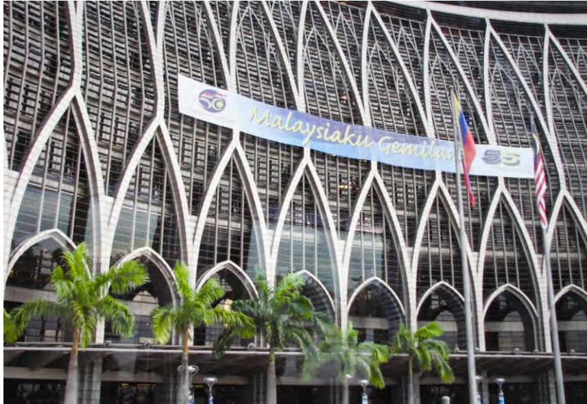
Şekil 4.5.6: Putrajaya, Malezya'daki Malezya Maliye Bakanlığı binası için mimari tasarım ifadesi olarak geleneksel motifle entegre edilmiş güneş kırıcı cihazlar
