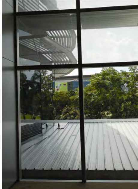
Şekil 3.2.5: Gün ışığının bina iç mekanlarına girmesini sağlayan güneş kırıcı uygulaması.
