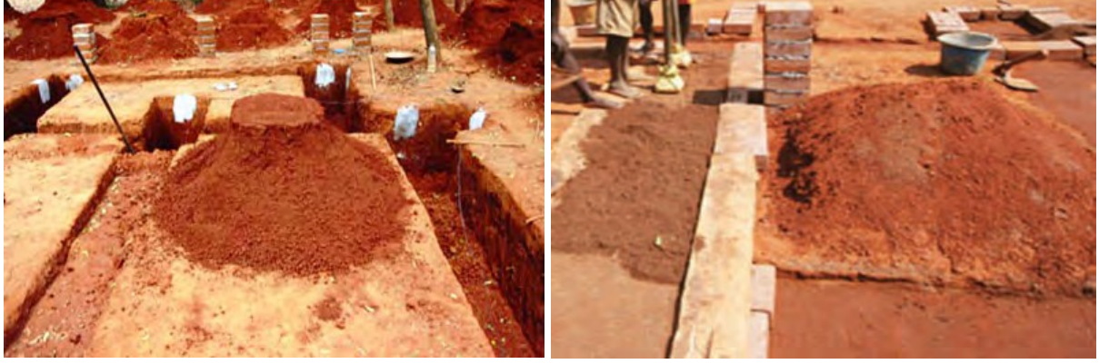
Şekil 4.1.1: Hindistan'da inşaat sürecindeki stabilize sıkıştırılmış toprak temeller
