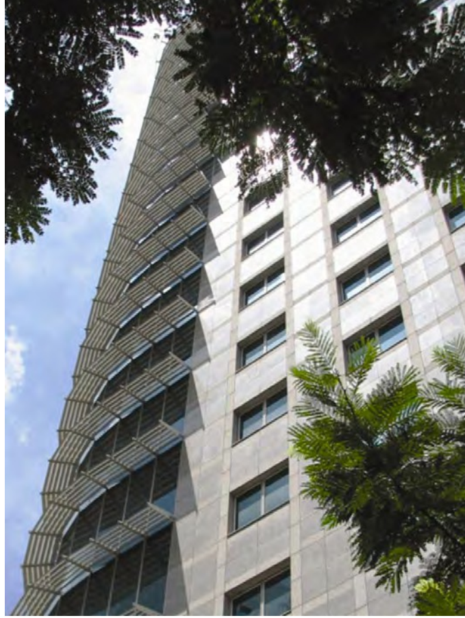
Şekil 4.5.10: Tropik bölgelerdeki binalar için diğer teknolojilerin yanı sıra uygun duvar/pencere oranı ve yeterli güneş kırıcı cihazlarla mümkün kılınan düşük ETTV'li bina cephesi
