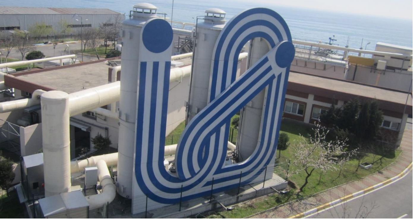
Fotoğraf 4 Küçükçekmece Ön Arıtma Atık Su Tesisi
