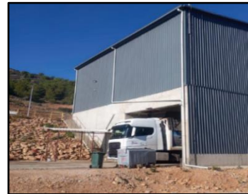
Gazi Paşa Katı Atık Transfer İstasyonu
