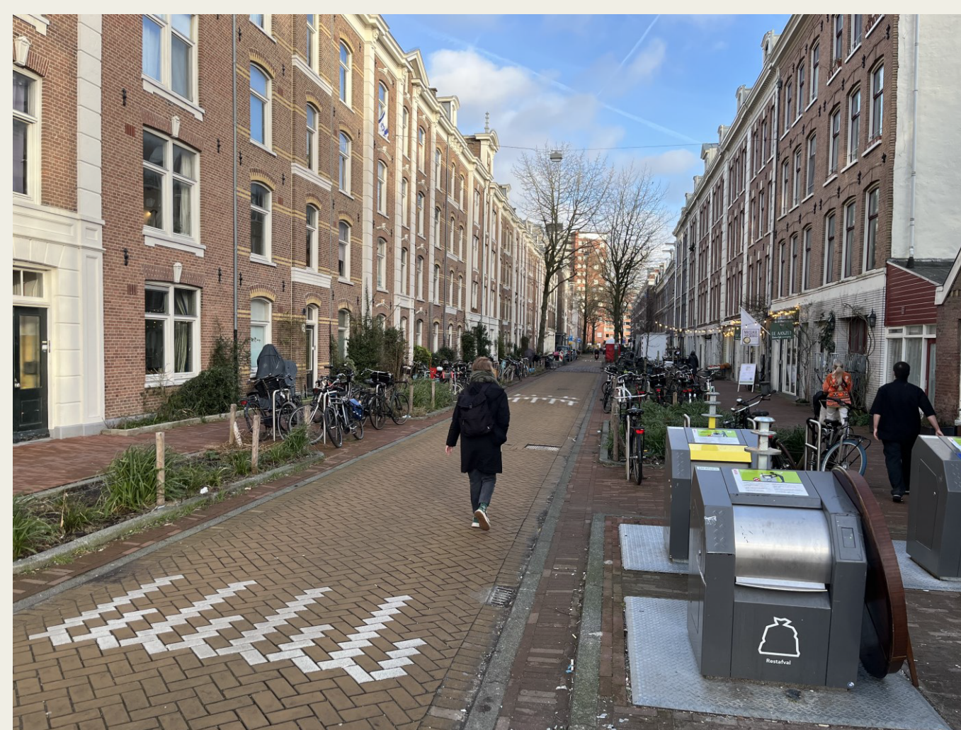
Sokak peyzaj dönüşümü örneği Amsterdam - Cadde üzerindeki park yeri kaldırıldı Fotoğraf: Fredrik Pettersson-Löfstedt
